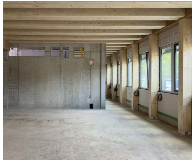
Rohbau eines Bürogebäudes in Holz-Beton-Verbundbauweise
