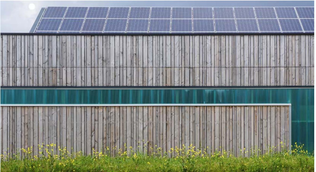
Moderne Fassadengestaltung mit Holz und Glas sowie integrierter Fotovoltaikanlage.
