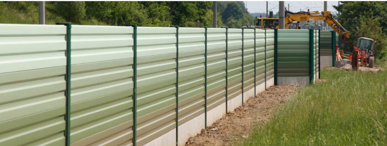
Beispiel einer Schallschutzwand aus Aluminiumelementen
